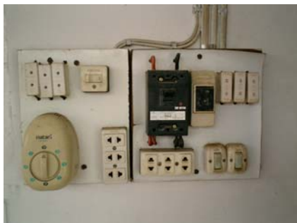
ການຕິດຕັ້ງບ່ອນປັກສຽບໄຟ ແລະ ບ່ອນປິດ-ເປີດໄຟ ທີ່ບໍ່ຮັບປະກັນຄວາມປອດໄພ
