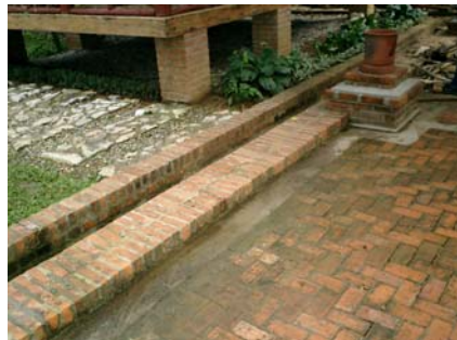
ນັກທ່ອງທ່ຽວ ສາມາດພະລາດລົ້ມໄດ້ງ່າຍ ໃນຮ່ອງລະບາຍນ້ຳແບບນີ້
